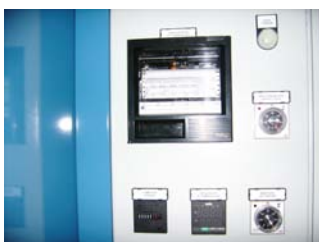
Enregistreur multivoies Multichannel recorder
